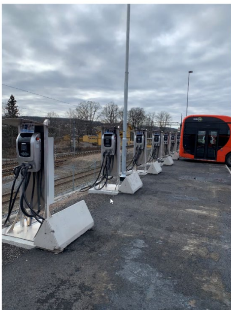
Figur 3 – Bilde av depoladere som følger bussene (semihurtig AC plugg lader, GB/T )
