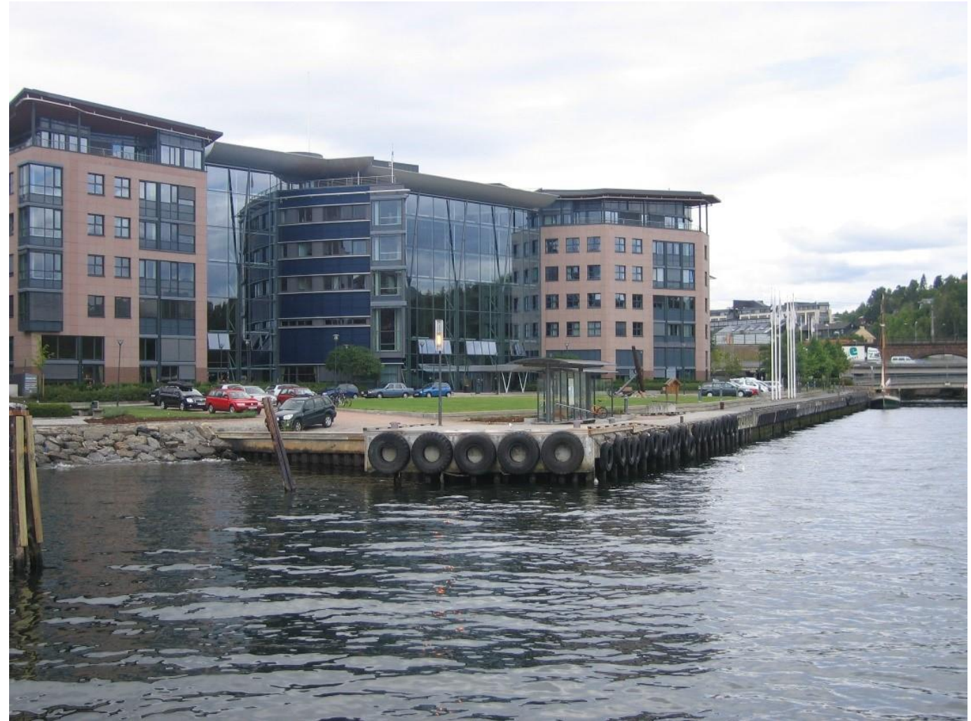
Lysaker brygge - kan bli oversvømmet ved høyvann
