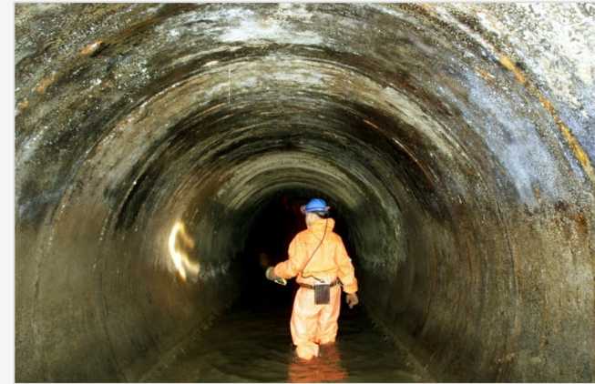
Infrastruktur under bakken
