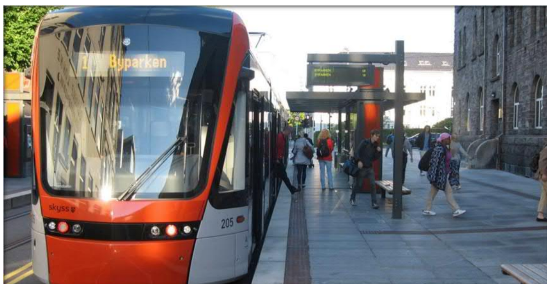
Figur 101: Bybanen i Bergen. Av – og påstigning skjer trinnfritt og med liten avstand mellom plattformkant og vogn. Det er høystandard stoppesteder med ledelinjer og informasjonsskilt. Systemets stivhet gir høy grad av forutsigbarhet, også hvor banen stanser på stasjonen.
