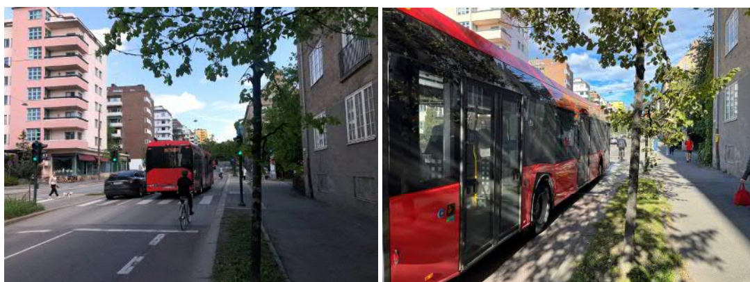
Figur 46: På Marienlyst er det ikke plass til sykkelfelt bak holdeplassen. Bussene forsinkes av syklist ved innkjøring til holdeplass, og syklist må enten vente bak bussen, kjøre forbi på utsiden eller på selve holdeplassen. (Foto: Sweco).
