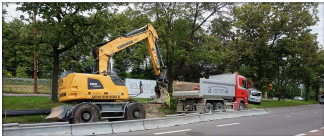
Figur 98: Oppigjennom årene har det foregått mye gravearbeid på og langs Ring 2, noe som gjør det vanskelig å vite hvor mye røtter som er blitt fjernet. Blant annet er det store anlegg for vann og avløp under bakken. Bildet viser graving ved Fayes gate i Kirkeveien, trolig for å legge ned rørene til venstre i bildet (Foto: Tonje Lysø).
