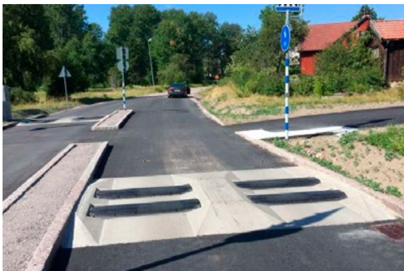
Figur 2.17. Dynamisk fartshump som presses ned ved høy vekt, som for eksempel når en buss kjører over. Bildet er hentet fra Trafikkförtningen Region Stockholm sin Riktlinjer Utformning av infrastruktur [12].
