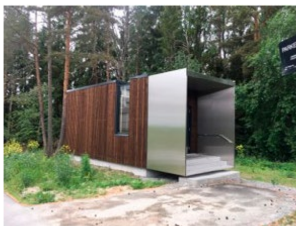
Figur 5.7. Eksempel på servicehus for førere, fra Åsbråten (Sporveiens servicehus). Foto: Ruter As.
