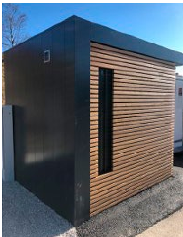
Figur 5.8. Eksempel på servicehus for førere, fra Fjerdingby (Vikens servicehus). Foto: Ruter As.
