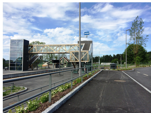
Figur 4.9. Etter oppgradering av Råde stasjon er forholdene fysisk godt tilrettelagt for så vel innfartsparkering som overgang tog/buss.
