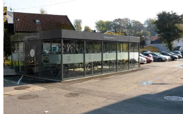
Figur 4.4. Jernbaneverkets sykkelparkering i hus og overbelastede bilparkering på Moss stasjon.
