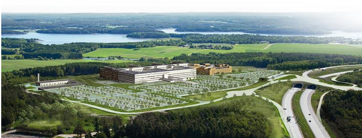
Figur 4.14. Nytt sykehus er under bygging på Kalnes ved E6 nord i Sarpsborg. Biltilgjengeligheten er god, men den isolerte beliggenheten gjør det utfordrende å etablere et attraktivt kollektivtrafikktilbud.
