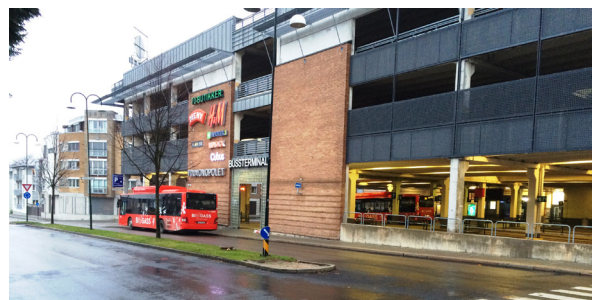
Figur 4.7. Halden busstasjon med jernbanestasjonen i bakgrunnen øverst, Haldens sentrumsholdeplass ved Parken i midten og bussterminalen i Sarpsborg sentrum integrert i kjøpesenter nederst.
