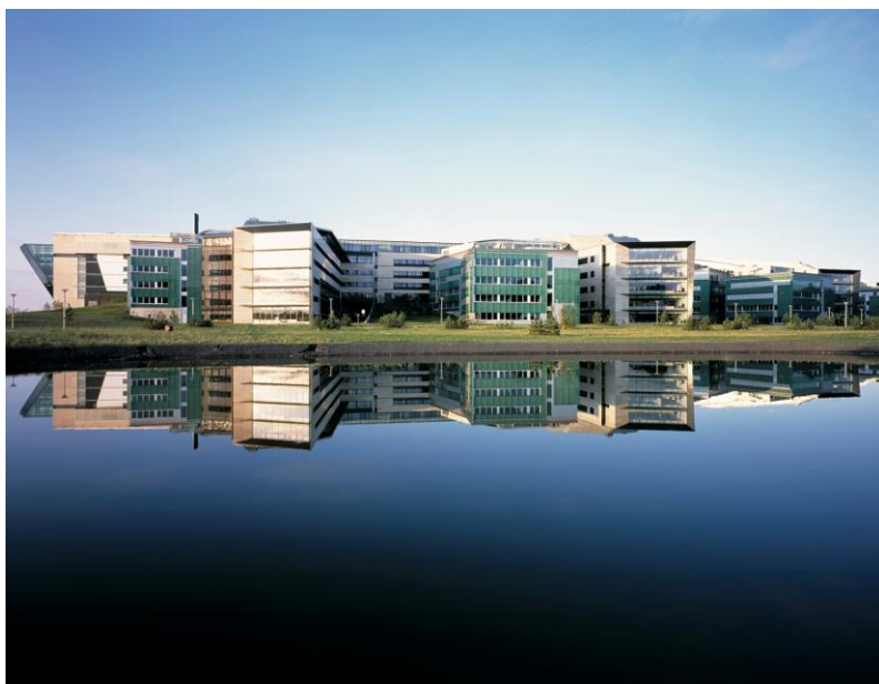
Figur 1.1. Kontorbygget til Telenor på Fornebu
