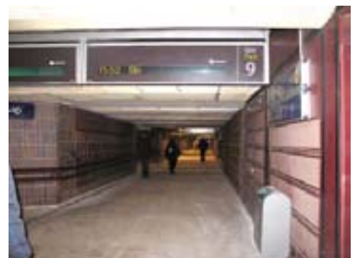
Figur 2 Behov for oppgradering av gangkulvert under sporene på Oslo S (foto: Anne Marstein)
