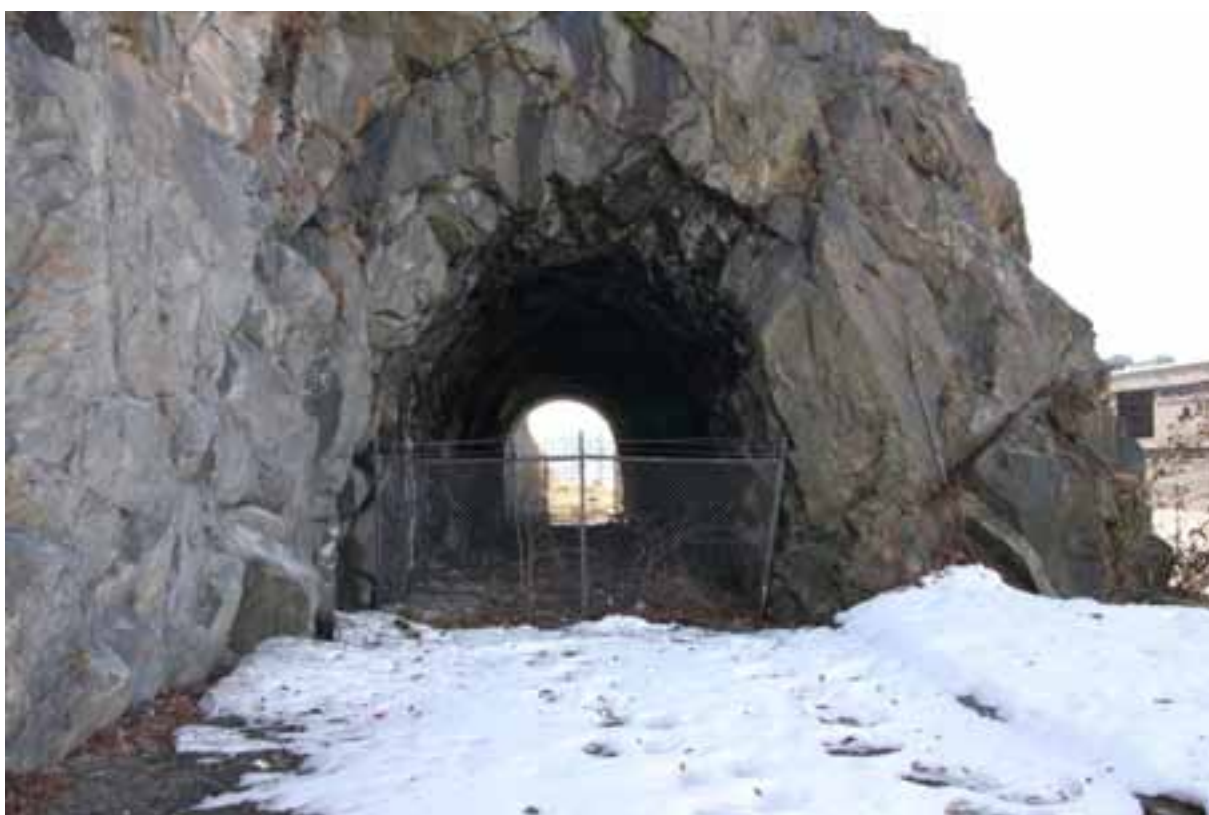
Eksisterende tunnelportal langs festningsmuren på Akershusstranda som er foreslått benyttet til Fjordtrikk i alternativ 4A/B. [Foto: Sweco Norge AS]
