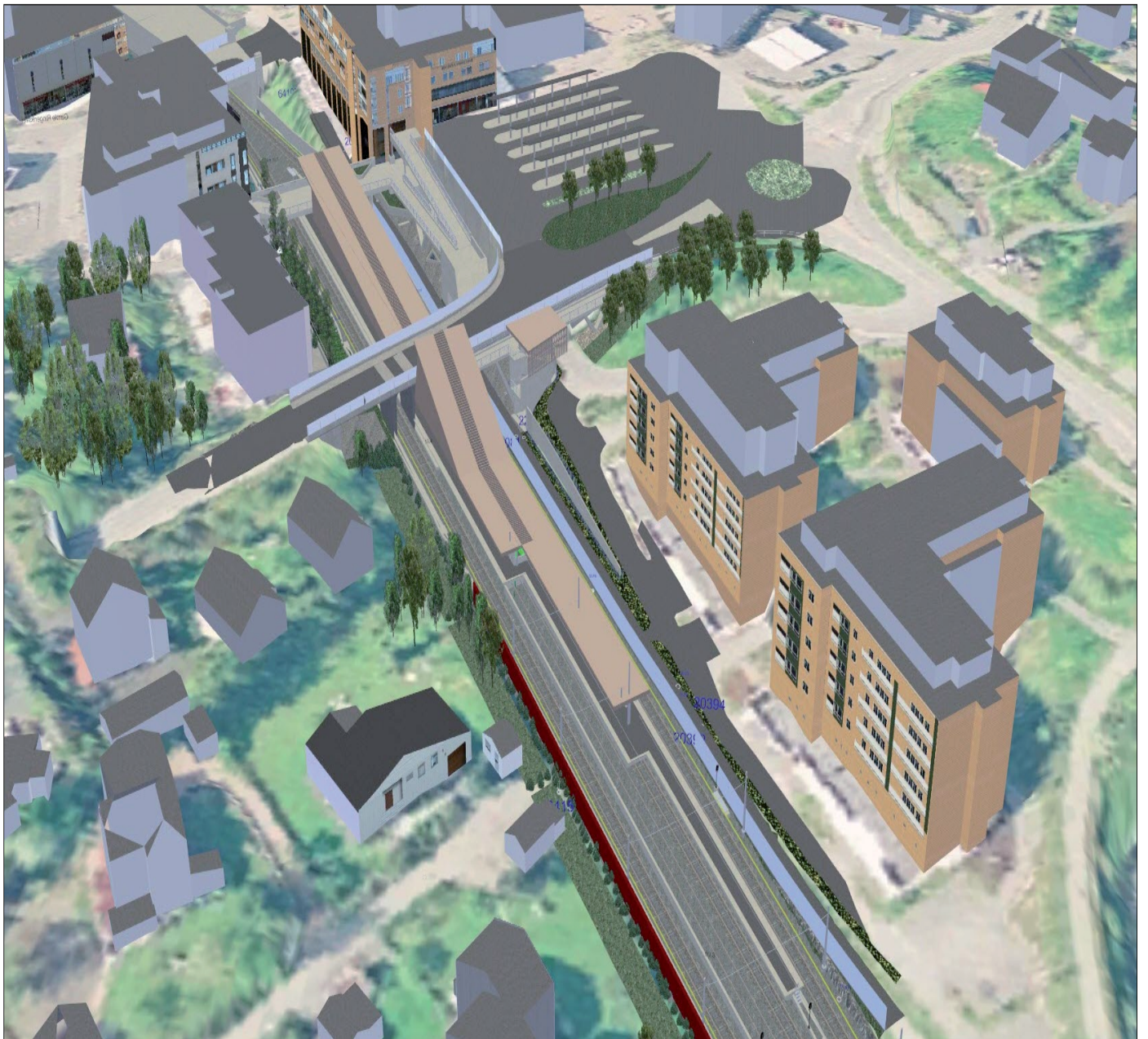
Øverst til venstre: Anleggsarbeider på Bekkestua. Øverst til høyre: Jar stasjon i ferd med å ferdigstilles for trafikk med både metro og trikk. Nederst: Illustrasjon av fremtidig løsning på Bekkestua, med metro, trikk og buss.
