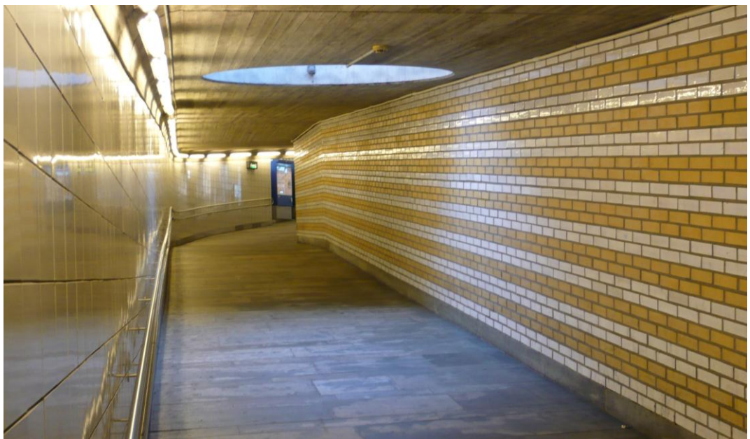
Figur 8 Nedgang til T-banestasjon på Helsfyr i Oslo. Det er god håndlist på den ene siden, men rampen er svært bratt. Belysningen er god men kan virke blendende.
