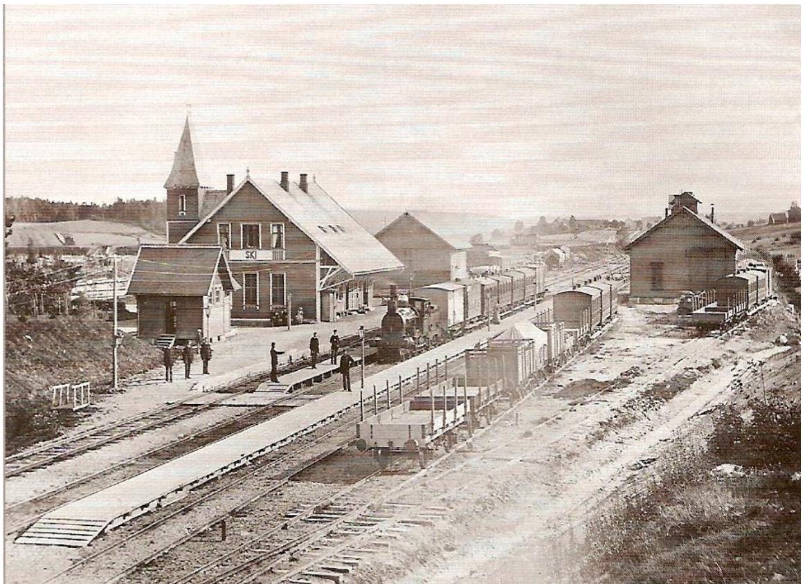
Figur 6.6. Ski stasjoner et viktig knutepunkt, med bussholdeplasser helt inntil togplattformen. Stasjonen har anstrengt kapasitet, og antall spor til plattformer er som ca 1880. (Nederst, foto Norsk Jernbanemuseums samlinger.)
