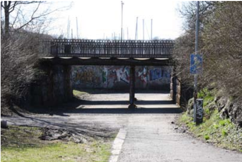
Undergang under jernbanen ved Skarpsnoparken
