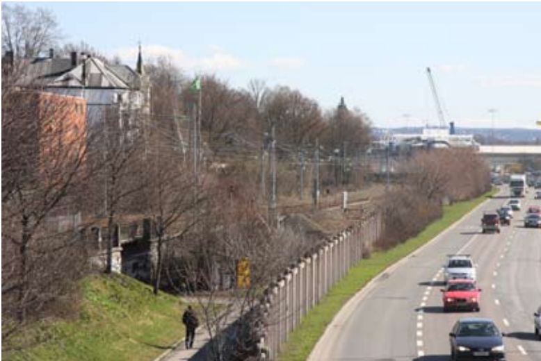
Sporområde og undergang på innsiden av E18 ved Skarpsno
