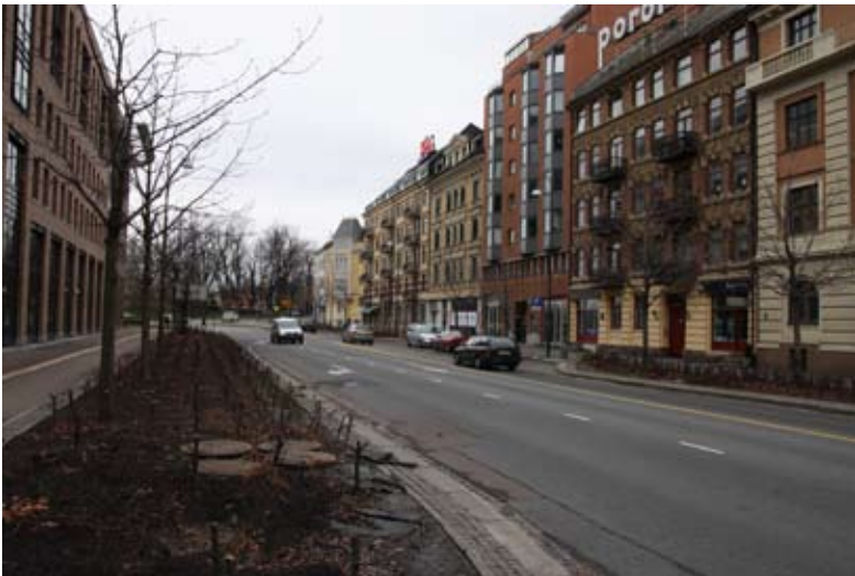
Munkedamsveien sett mot vest
