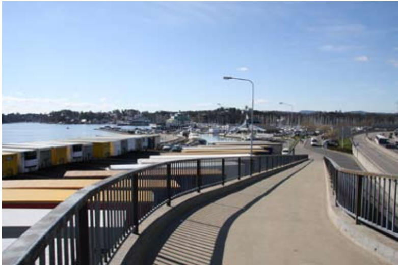
Areal på utsiden av Hjortneskrysset sett fra rampe på gangbro over på Tinkern
