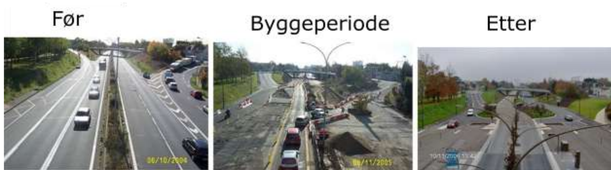
Figur 2: ombygging av bilfelt til superbusstrasé i Nantes, Frankrike
