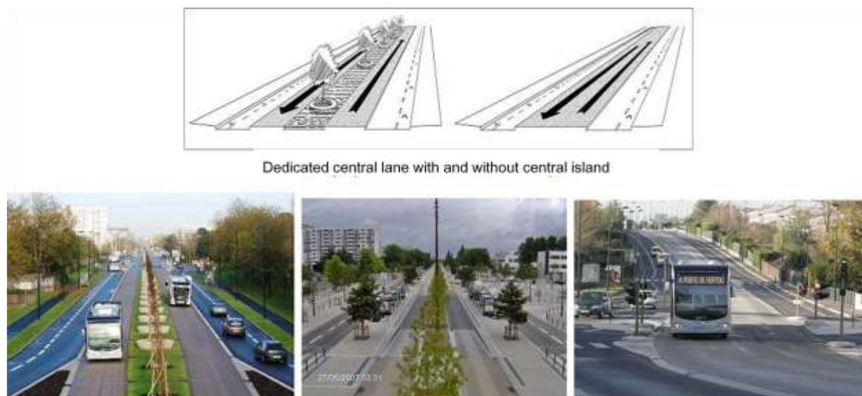
Figur 1: Egne traseer og full prioritet i vegkryss og rundkjøringer for superbussen i Nantes, Frankrike
