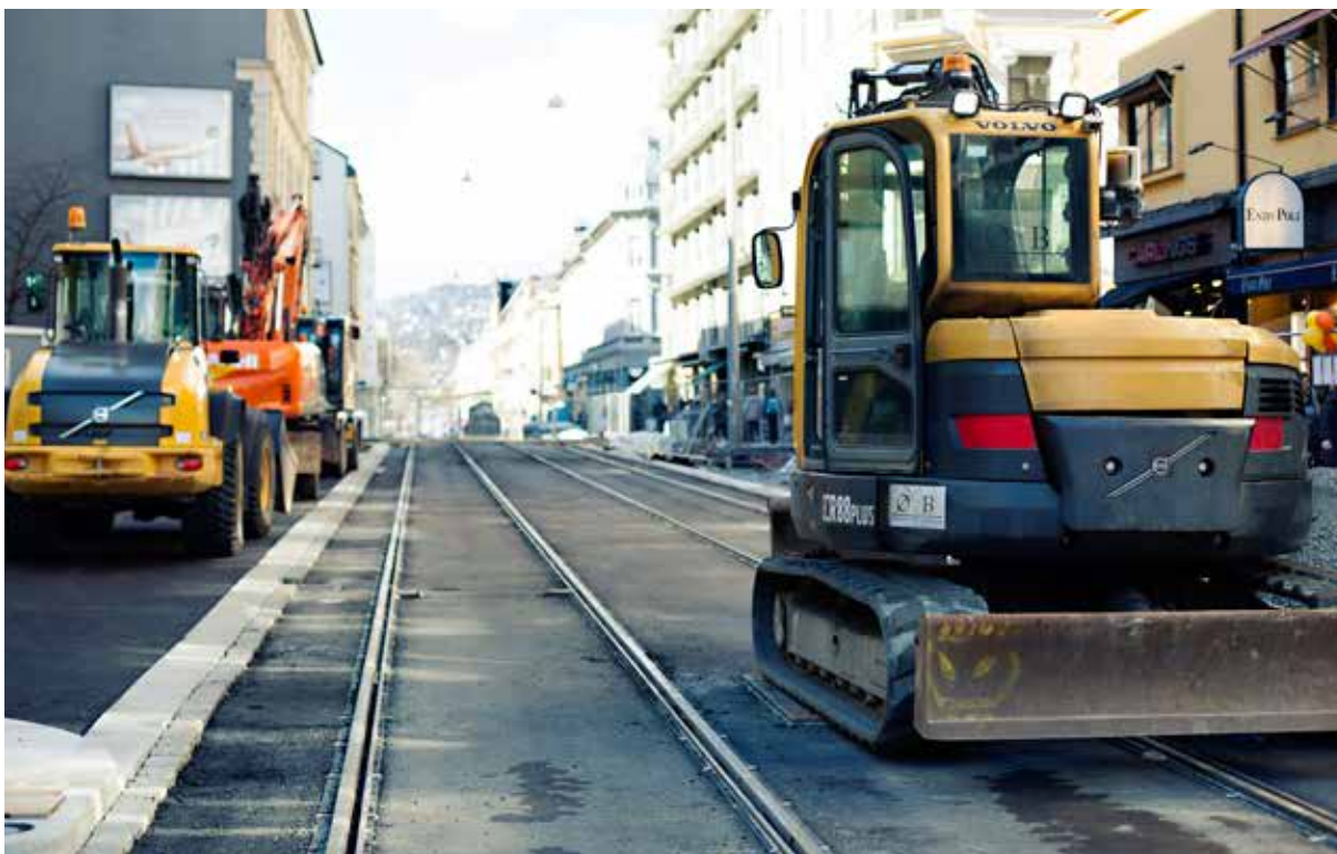
Bogstadveien under oppgradering
