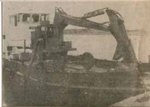
En 14-tonns Brøyt-gravemaskin bringes fra fastlandet til en øy utenfor Horten.
