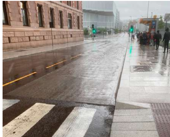
Figur 1.7. Betongdekke på Tollboden holdeplass i Oslo. Denne er etablert med 18 cm tykt betongdekke. Størrelsen på betongplata er 30 x 3 meter. Her er det også etablert avlastingsplate av stål med pappmembran over i hver ende av plata. Foto: Norconsult.
