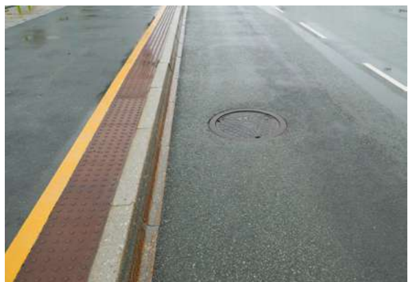
Figur 1.9. Smal profilkantstein på holdeplass Moholt studentby i Trondheim. Kumlokk i kjørebane bør unngås på holdeplass Foto: Ruter As.
