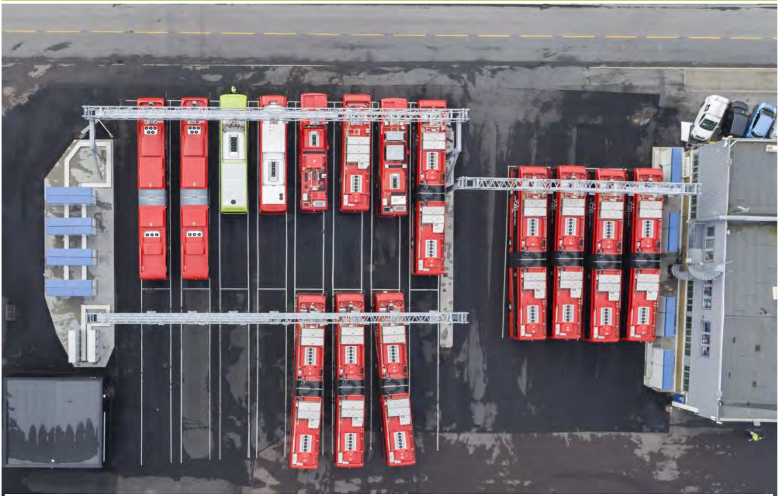
Bussanlegget i Strømsveien har kapasitet til å lade 30 busser samtidig. Foto: Redink/Ruter
